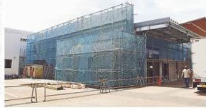
本社工場の敷地内に建設中の新工場。射水市戸破
